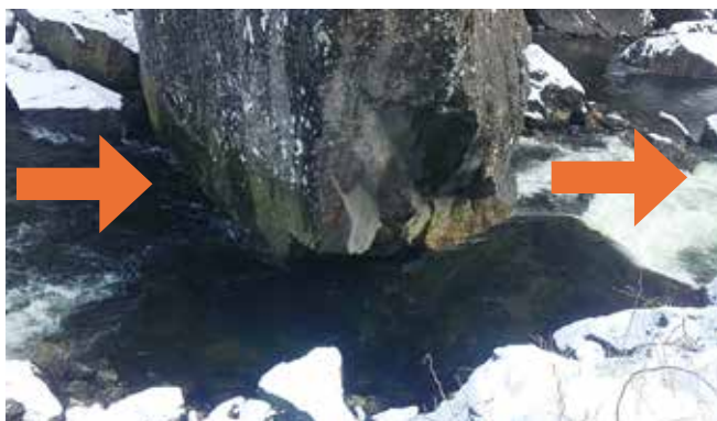
Eksempel på underspyling ved liten vannføring.
