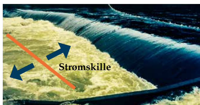
Menneskeskapt terskel som medfører en valse nedstrøms.
